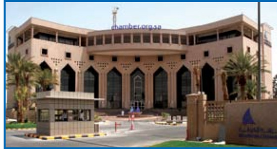
استحدثت كابينة حراسة جديدة لمبنى الغرفة
